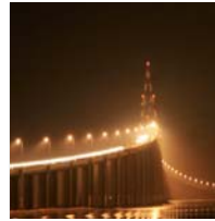
Pont de Saint Nazaire
