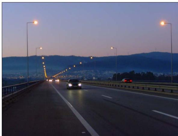
La zone de jonction près de Viana do Castelo avec le pont sur la rivière Lima représente la section de la concession ayant la plus importante consommation d'énergie : 340 MWh pour 291 points lumineux (248 x 250W et 43X 150W équipés avec des lampes Sodium haute pression et de ballasts ferromagnétiques).
